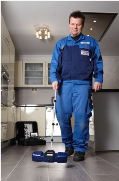
Fig. 7: Localização da cabeça de câmara debaixo do solo
